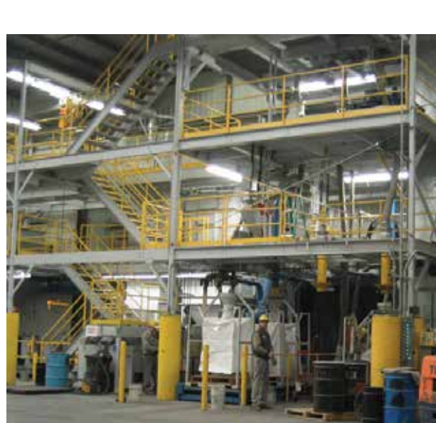
连续催化剂取样系统
