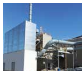
此袋滤室可以消除空气污染，并在排气之前捕获贵金属粉尘。
